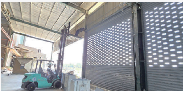
10 bộ cửa cuốn được thi công
